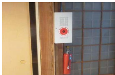
自動火災報知設備の新設
