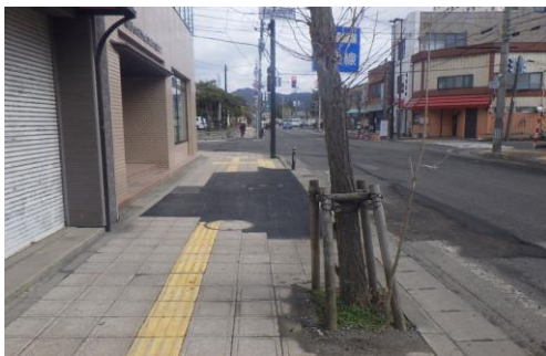
電線共同溝本体工事(着手前)
