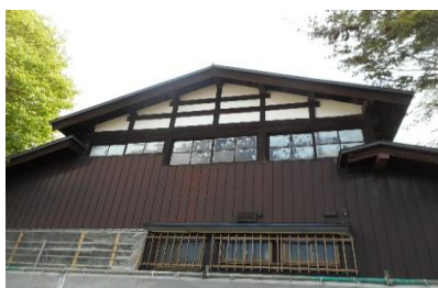
サイディング張り外壁を板張りに変更
