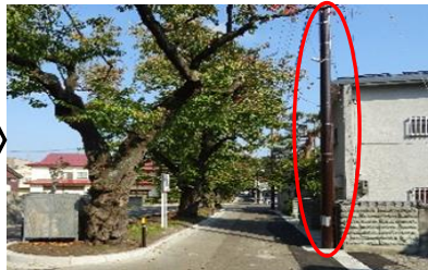
電柱電線類の統合 景観色の鋼管柱に修景 【統合移設後】
