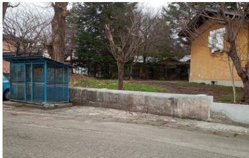
危険ブロック塀(撤去後)
