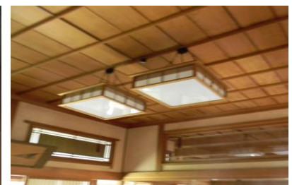
非構造部材(吊り下げ灯具)の更新
