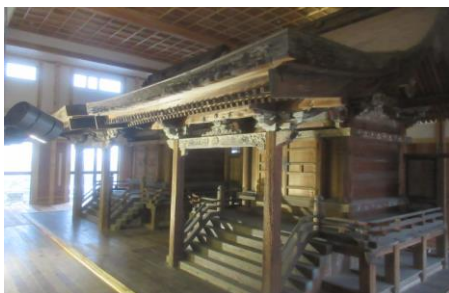
覆屋内部完成(重要文化財二社)
