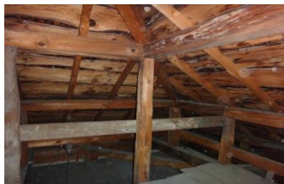
釘を増し打ちし、水平構面の剛性確保
