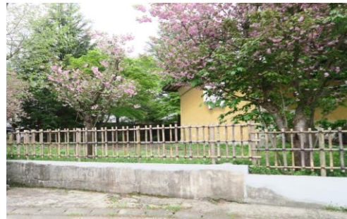
竹垣(四ツ目垣)設置
