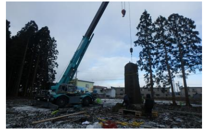
支障木伐採・石碑移設・お社解体 (令和元年度)
