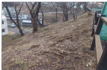
北側斜面の刈り払い(完了後)
