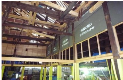
一部既存壁を構造用合板で補強
