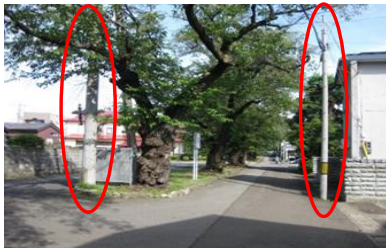
電力柱(植樹帯) NTT柱(南側路側) 【統合移設前】
